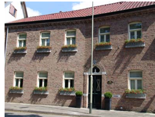
Jodenstraat 11. De gevel van het huis loopt gelijk aan de kromming van de weg. De gevel is in zijn totaliteit vernieuwd.
