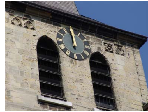
Gotische friezen in de bovenste geleding van de kerktoren.
