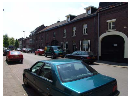
Huizen aan de zuidkant van de Peschstraat.
