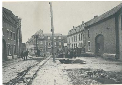
In 1926 wordt de Kötelbeek overkluisd.
