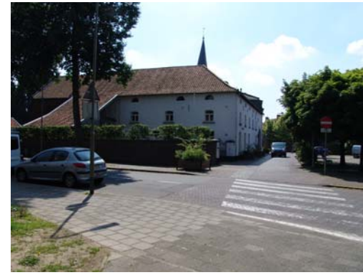
Voormalige Brouwerij 'de Kroon', op de hoek van de Marcellienstraat en de Jodenstraat.
