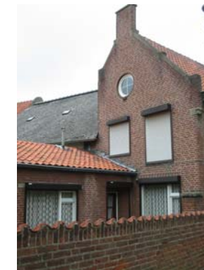
De achterzijde van Marcellienstraat 14. Opvallend is de hoekoplossing.
