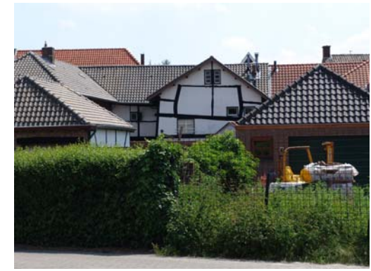
Vakwerkbouw aan de achterzijde van Marcellienstraat 11, gezien vanaf de Brouwersstraat (A, B, C).
