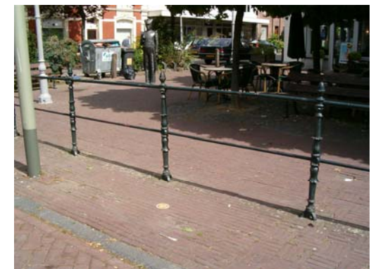
Het gietijzeren hekwerk heeft waarschijnlijk oorspronkelijk deel uitgemaakt van de brug over de Kötelbeek.
