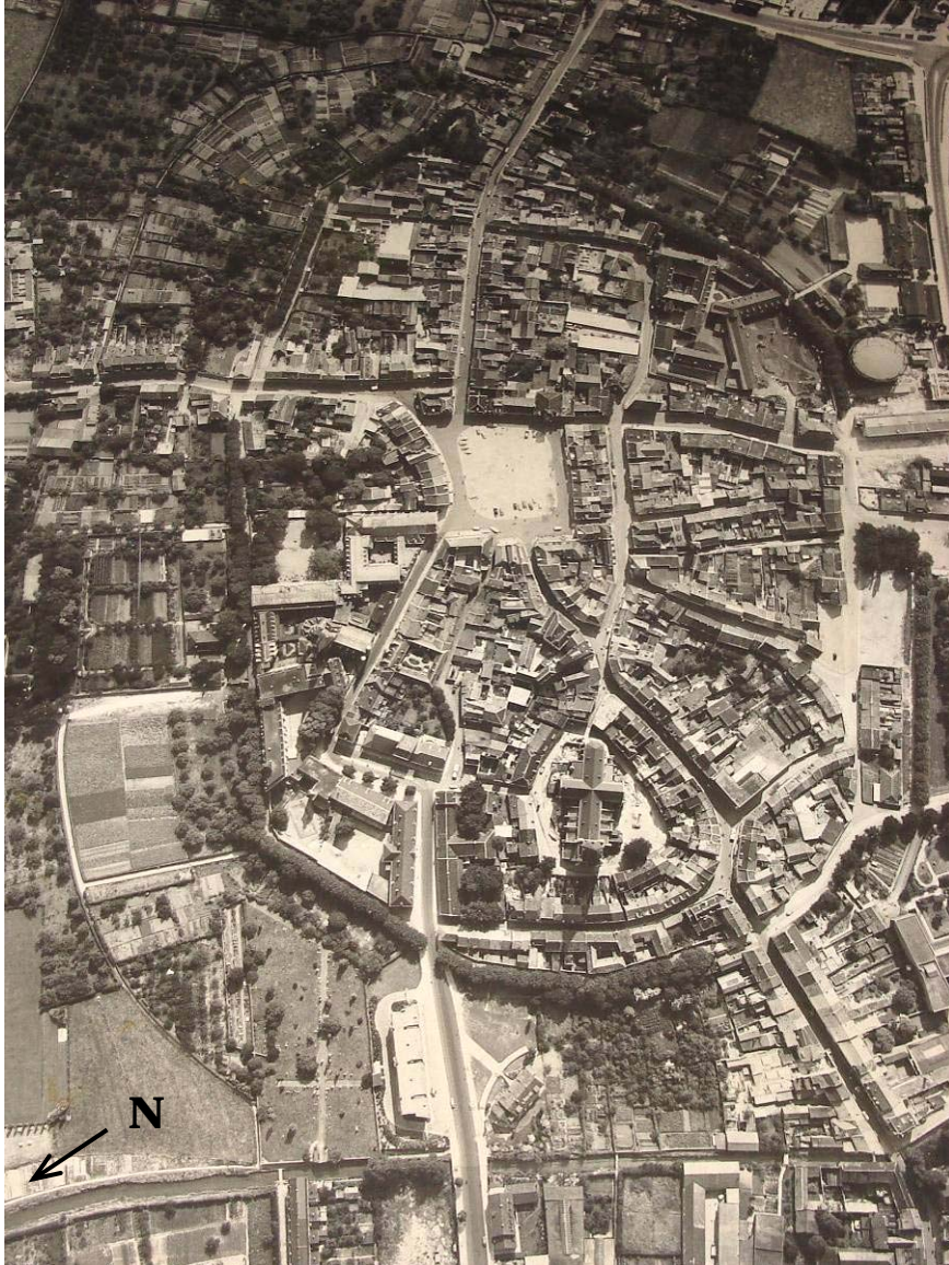
Luchtopname van de binnenstad van Sittard, 1956. De blikrichting is van west naar oost. Herkomst: Digitale opname van analoge foto in het stadhuis, Hub. Dassenplein Sittard.
