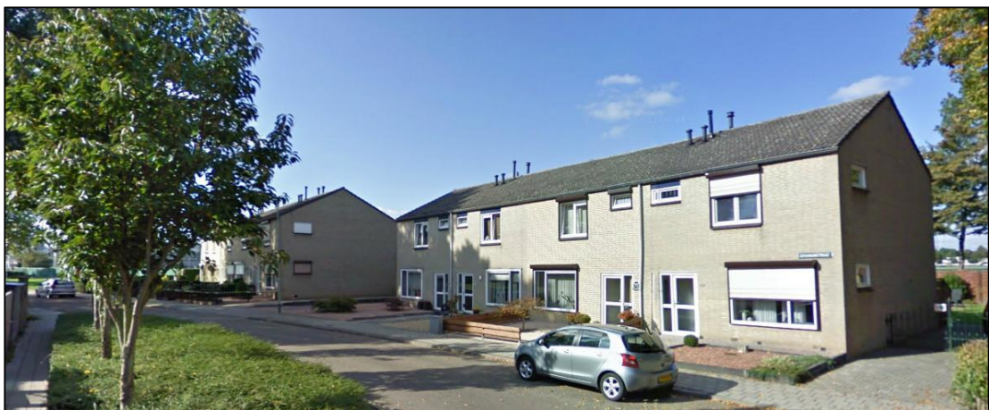
Figuur 1.4: hoek Seringenstraat - Geraniumstraat, gezien in westelijke richting
