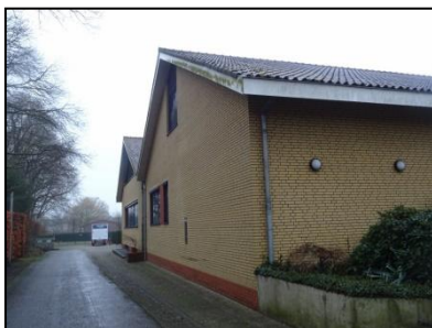
Figuur 6. De zuidzijde van de bebouwing.
