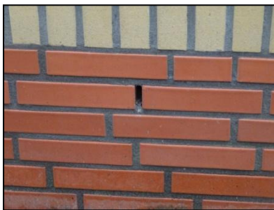
Figuur 11. Open stootvoeg die toegang geeft tot de spouwmuur
