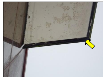
Figuur 13. Ruimte achter betimmering aan de noordzijde van de bebouwing.
