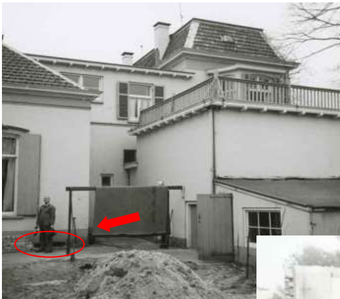
Figuur 5: Achterkant 'Villa van Coops'. In de rode cirkel is een lucht/ventilatie rooster zichtbaar. Bij de rode pijl de mogelijke ingang
