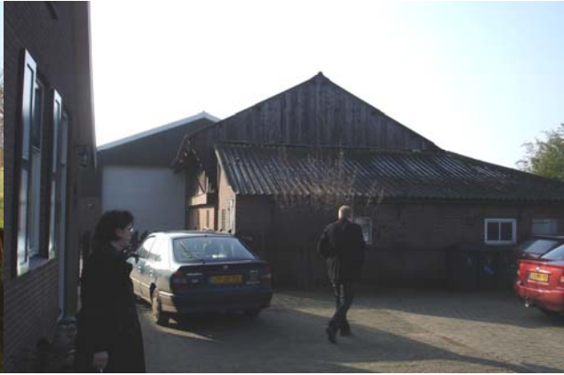
Kapschuur met aanbouw
