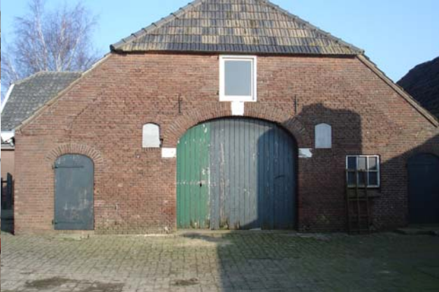
Achtergevel weer beter zichtbaar maken
