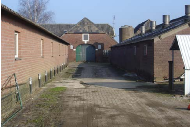
Achterzijde (sloop stallen)
