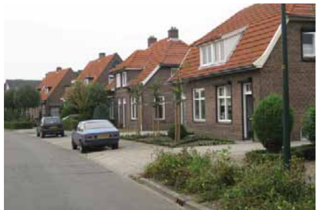
Arbeiderswoningen Wilhelminastraat Ruurlo.
