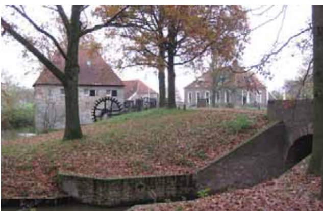
Mallemse molen, schutsluis en Muldershuis.
