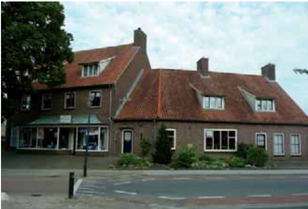
Dit pand op de hoek van de Nelissenstraat en de Voslaan in Beltrum is vlak na de oorlog opnieuw opgebouwd, nadat op 25 maart 1945 grote verwoestingen waren aangericht door geallieerde bombardementen. In de tegenoverliggende r.-k. school hadden de Duitsers munitie opgeslagen en ze hielden daar ongeveer 80 mensen gevangen als menselijk schild ( www.beltrum-online.nl ). In het rechter woonblok bevond zich oorspronkelijk op de begane grond ook een winkelpand.
