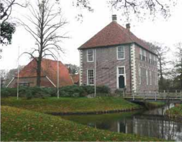
Huize de Kamp bij Neede. Op de hoeken zijn blokken van Bentheimer zandsteen ingemetseld. Tussen 1553 en 1741 heeft het geslacht Tengnagel de woonplaats in bezit gehad. De familie Ten Cate was eigenaar in 1789. Zij lieten het pand inkorten en verbouwen. Op het erf staat een ronde welput van Bentheimer zandsteen. Op de put staat het jaartal 1609. 56
