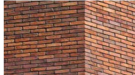
Bruin oranje gemêleerd metselwerk.
