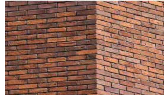
Bruin oranje gemêleerd metselwerk.
