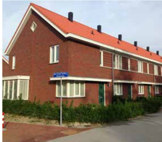
1. Rijwoningen aan de Wilgenlaan
