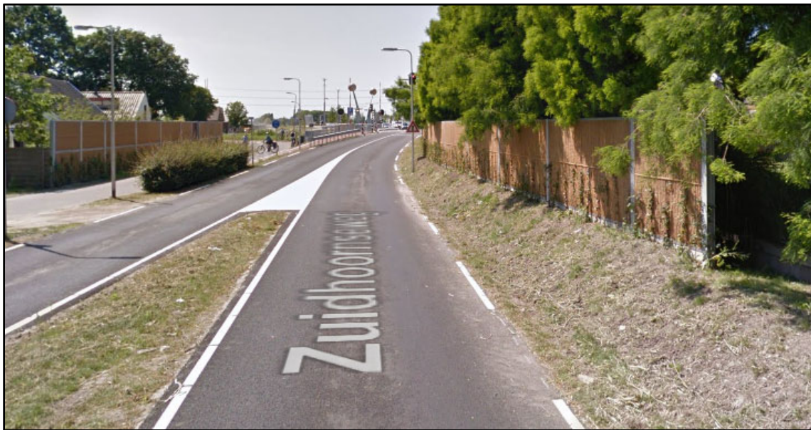
Figuur 3.3 Bestaande geluidschermen langs Zuidhoornseweg
