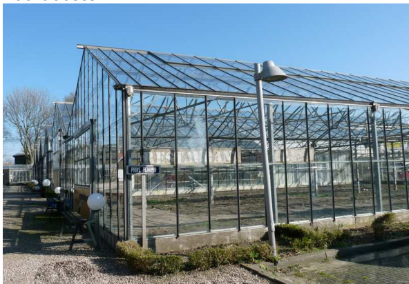
Figuur 9. Zicht op de meest westelijke kas. Foto genomen richting het oosten.
