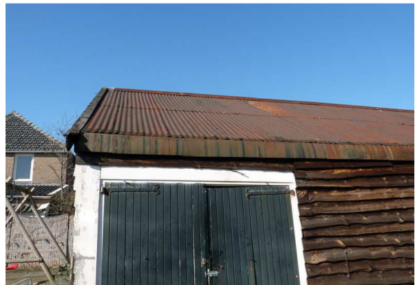
Figuur 8. Detail van het houten schuurtje, het dak is van metalen golfplaten.
