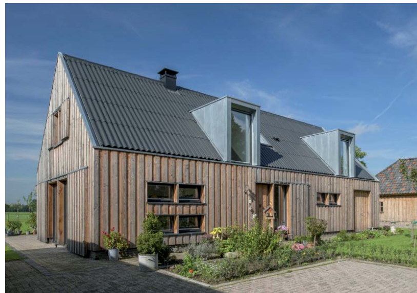
Schuurwoning, BAS architectuur
