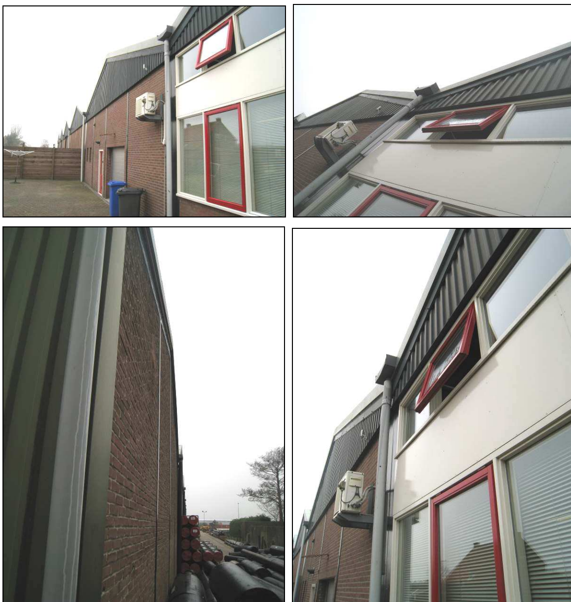
Figuur 4. Beeld van de volledig dichte gevel van de loods.
