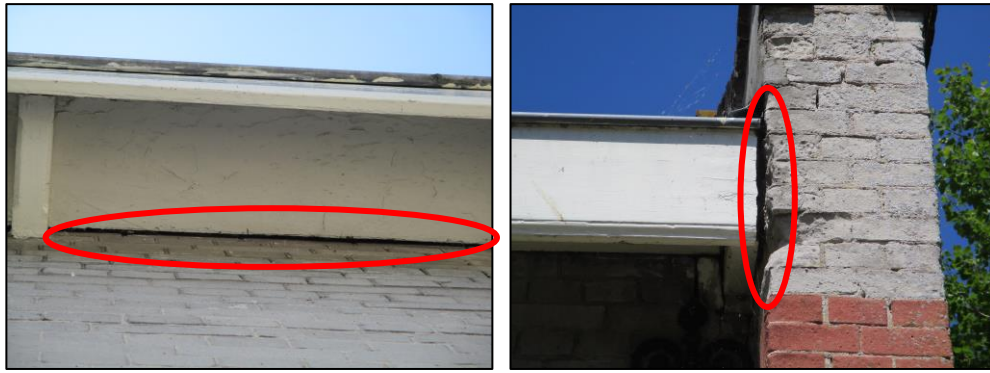
Figuur 5 Voorbeelden van aangetroffen openingen die vleermuizen toegang kunnen bieden tot geschikte verblijfplaatsen.
