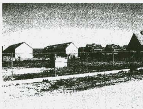
Foto 4 opname van de onderzoekslocatie
