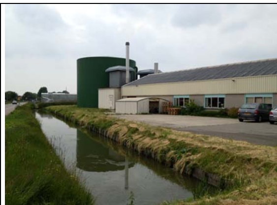
Foto 4: Leehove Lierweg 18, WKK op >65 m van plangrens van bedrijf Varekamp – De Zeeuw
