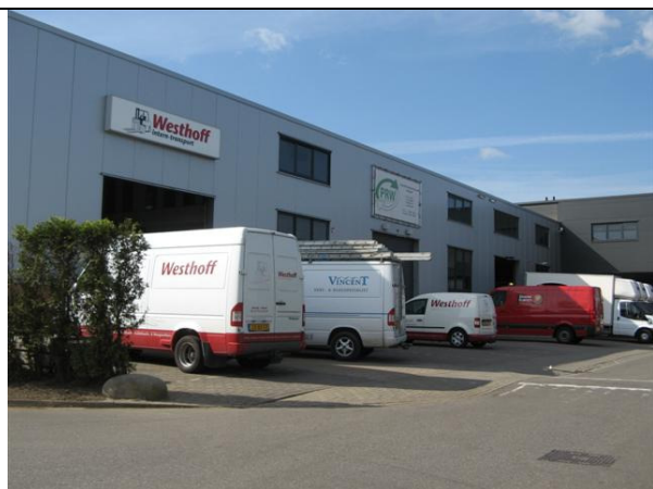
Foto 4: Bedrijventerrein Derde Hoeve
