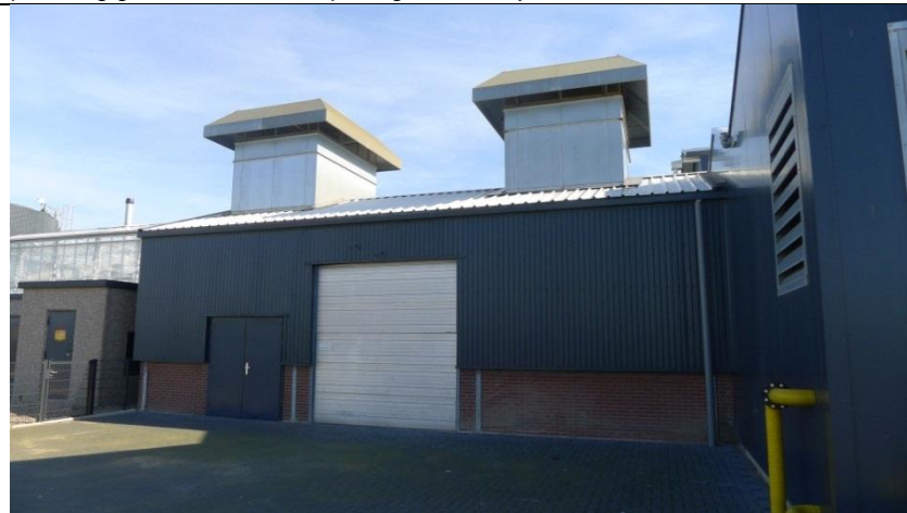
Aanzicht WKK1 gebouw met deuren en ventilatie kappen.
