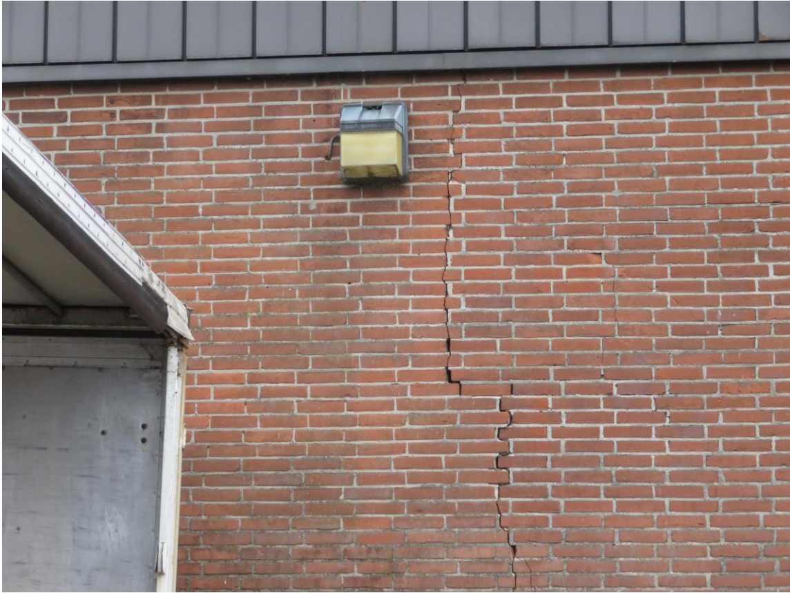
Scheur in de muur, met daarnaast verlichting en lossende vrachtwagen.
