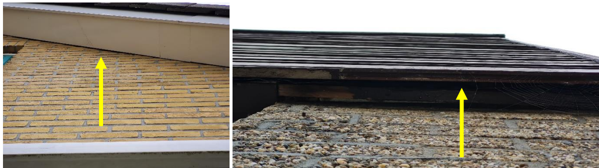
Figuur 5.1. Links: Middel Broekweg 77 met ruimte tussen de dakbelijsting en de muur. Rechts: Middel Broekweg 85 met ruimte tussen de muur en de houten omlijsting waar vleermuizen kunnen verblijven.
