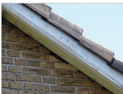
Foto 17: Openingen bij dakrand (westzijde woning).
