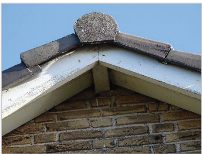
Foto 20: Openingen bij dakrand (westzijde woning).
