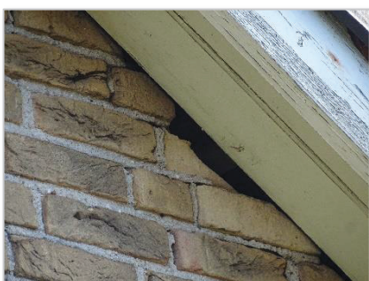
Foto 18: Openingen bij dakrand (westzijde woning).
