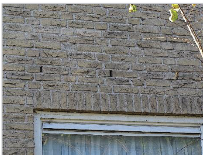
Foto 27: Stootvoegen in gevel (oostzijde woning).
