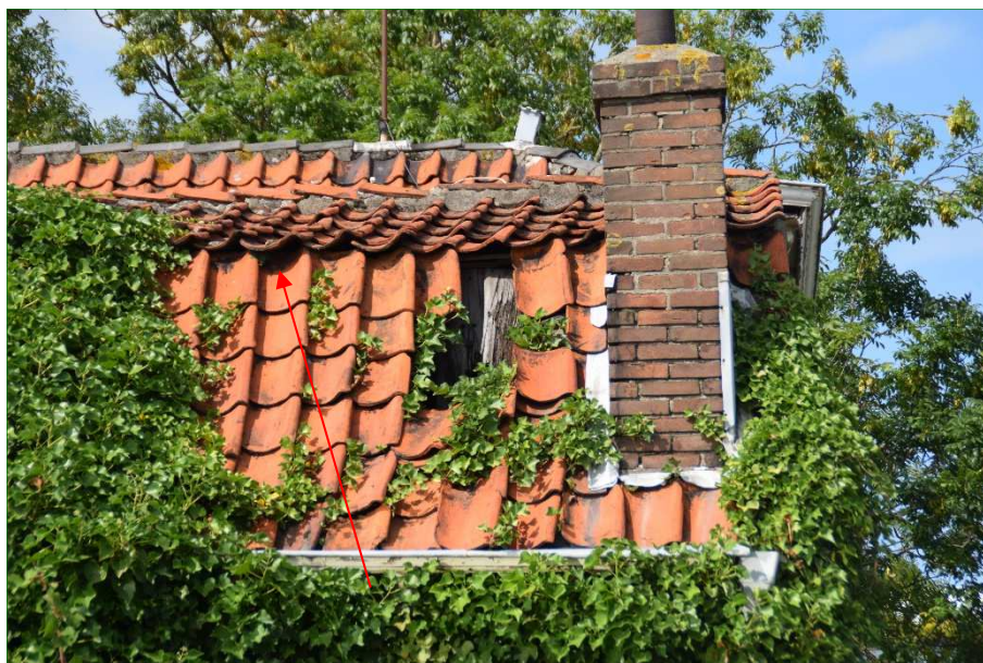
Kier onderdakpannen geeft mogelijk toegang tot ruimtes die geschikt zijn voor Huismus en Gierzwaluw.
