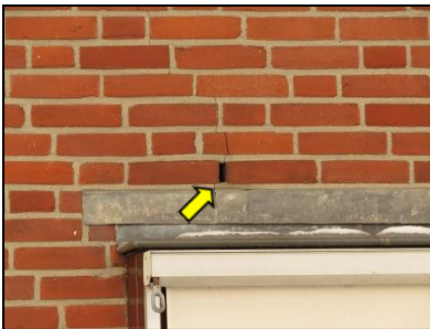
Figuur 12. Open stootvoeg mogelijke ingang voor vleermuizen.
