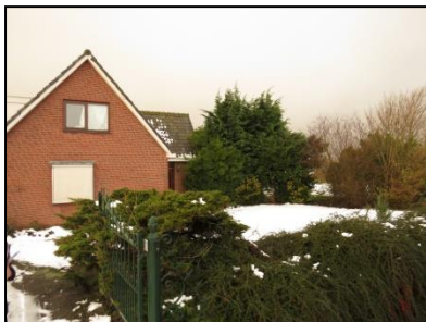
Figuur 3. Zicht westwaarts vanaf de entree (Maasdijk) op het woonhuis.
