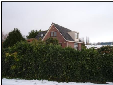
Figuur 4. Zicht oostwaarts vanaf het agrarische perceel op het woonhuis.
