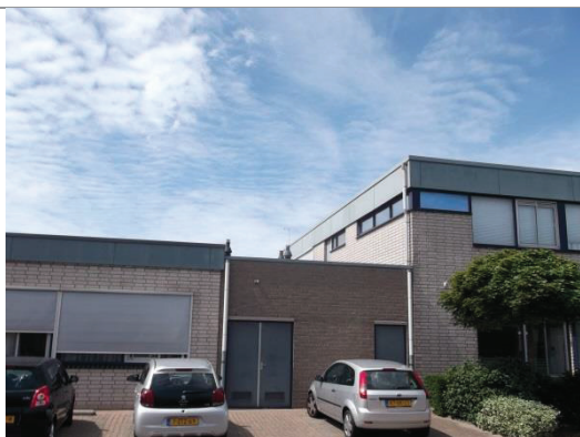
Foto 1: Het gebouw in het plangebied bestaat voornamelijk uit 1 bouwlaag met muren van drijfsteen, een plat dak en een omlijsting van plaatmateriaal.
