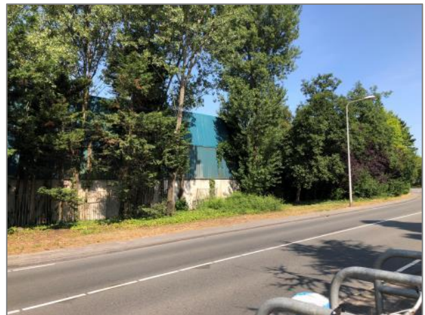
Sloperij langs de Dijkweg
