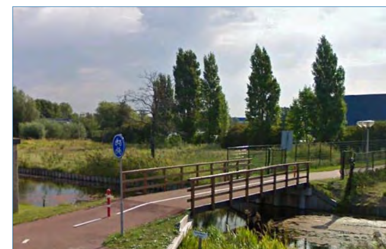
Houten fietsbrug in fase I
