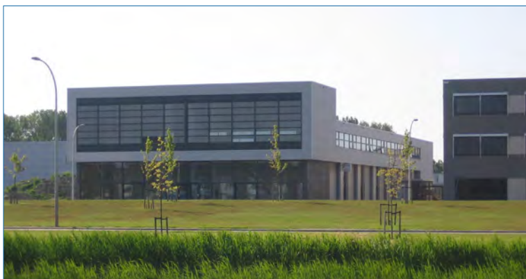
Kantorendeel als onderdeel van de totale bouwmassa
