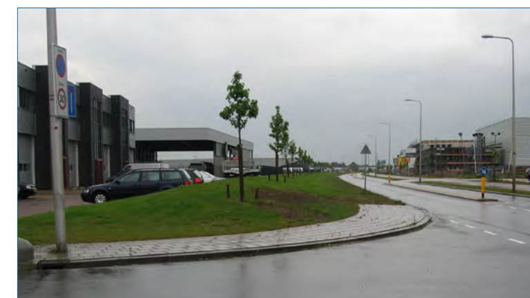
Groen talud langs de ontsluitingsweg
