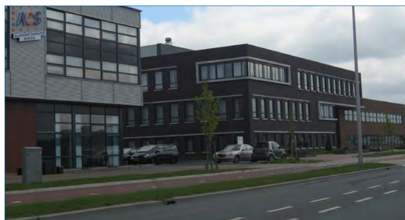
Fietspad en groen langs de centrale ontsluitingsweg
