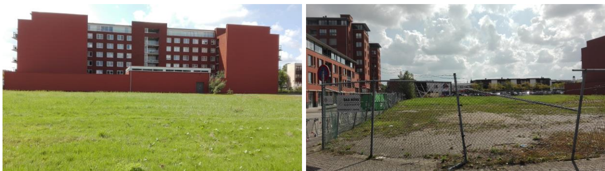
Figuur 3.2: Overzicht van het plangebied. Links het plangebied gezien vanuit het noordoosten en rechts het plangebied gezien vanuit het zuidoosten.
