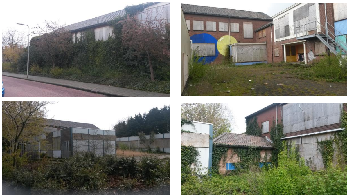
Figuur 2.2 Impressie projectgebied met het voormalige schoolgebouw Dalton Mavo.
