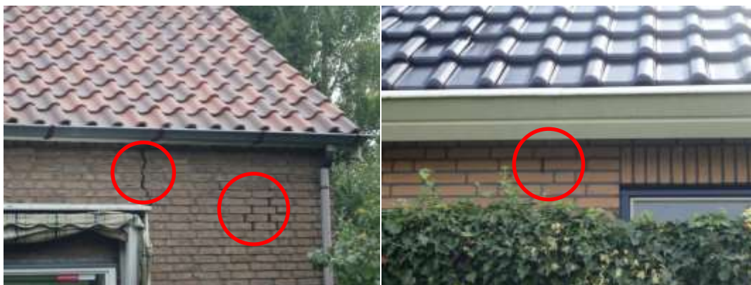
Figuur 4.9. Impressie woningen met spouwmuurgaten die vleermuizen toegang bieden tot de spouw (geschikte vaste rust- en verblijfplaats). Links: Swaandrift 4. Rechts: Swaandrift 2.
