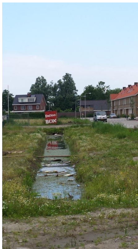
Ter hoogte van fase 3 is de nieuwe watergang smaller vormgegeven
