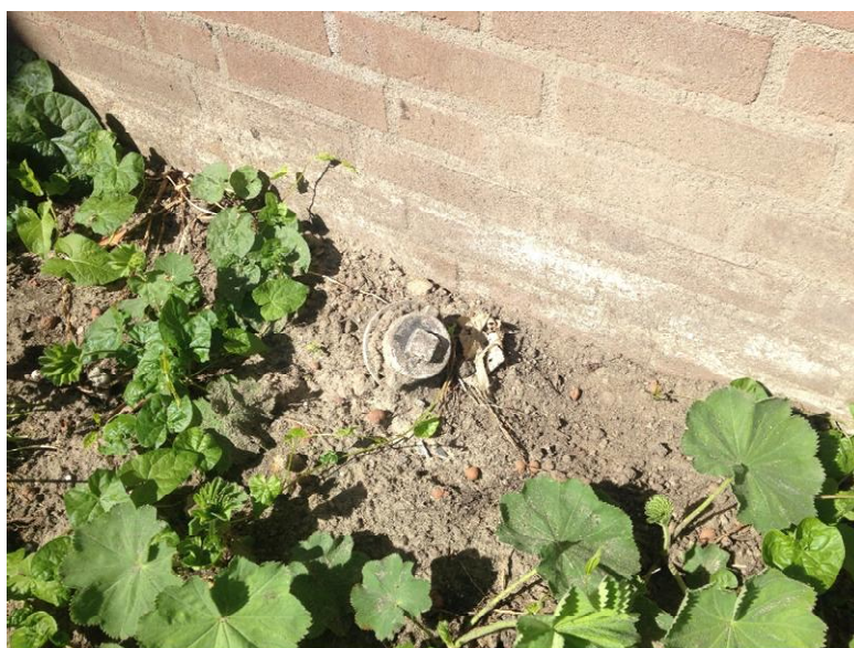
vulpunt van afgefulde ondergrondse olietank
