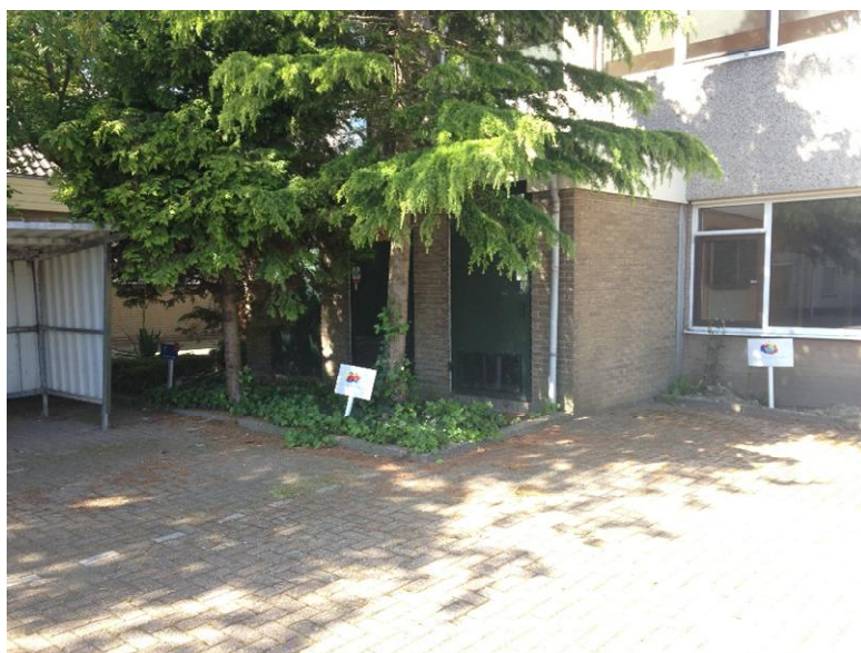
ligging voormalige bovengrondse olietank
