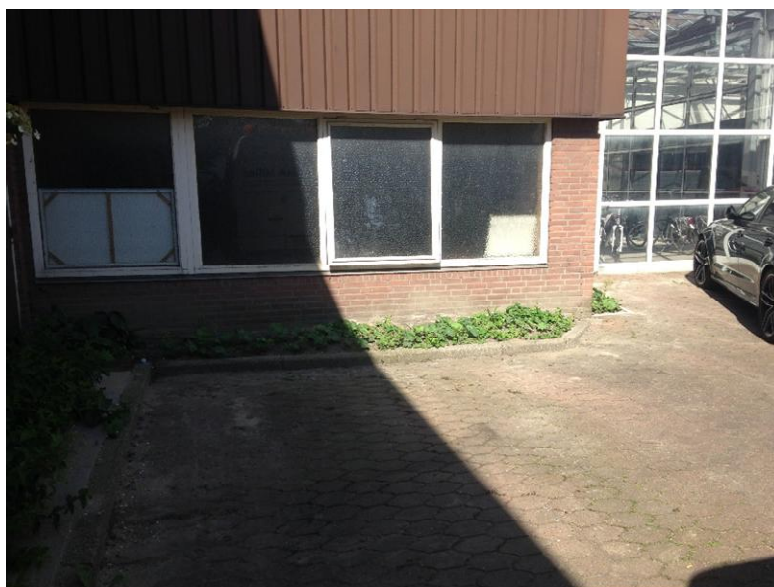
ligging afgefulde ondergrondse olietank
