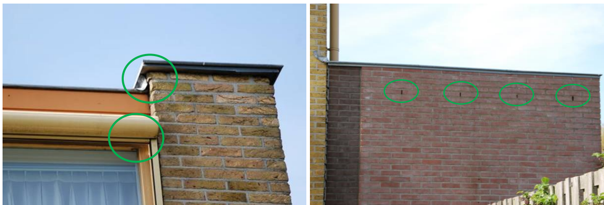
Figuur 5.2. Links: kieren en gaten (groene markering) onder de daklijsten en zonnewering van het woonhuis, geschikt voor vleermuizen om te gebruiken. Rechts: open stootvoegen in de aanbouw (groene markering), geschikt voor vleermuizen om te gebruiken.
