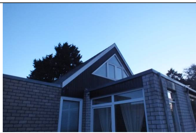
Foto 4. Gevel van de woning
