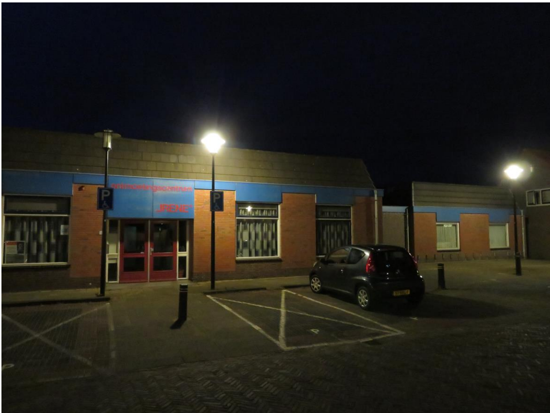
Felle straatverlichting is ongewenst bij de invliegopeningen van vleermuizen
