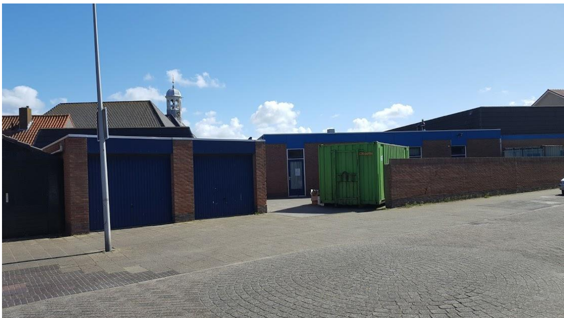
Figuur 5: garages en binnenplaats.
