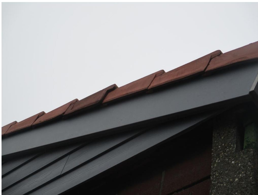
Figuur 3 Trespa beplating de ingang voor de vleermuis bij de kantpannen van de schuur (perceel II).
