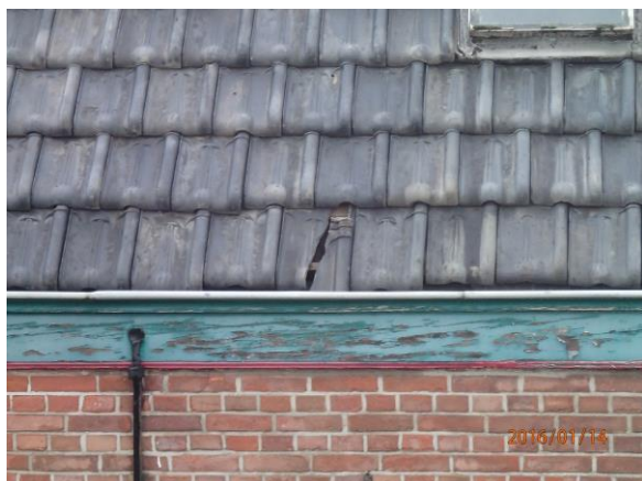
Foto 7. detail dakpannen Sand-Ambachtstraat 87
