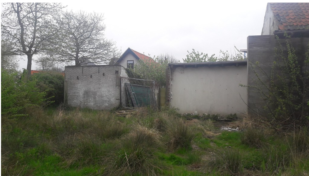
Uitbouw en schuur gezien vanaf de westzijde van het plangebied.
