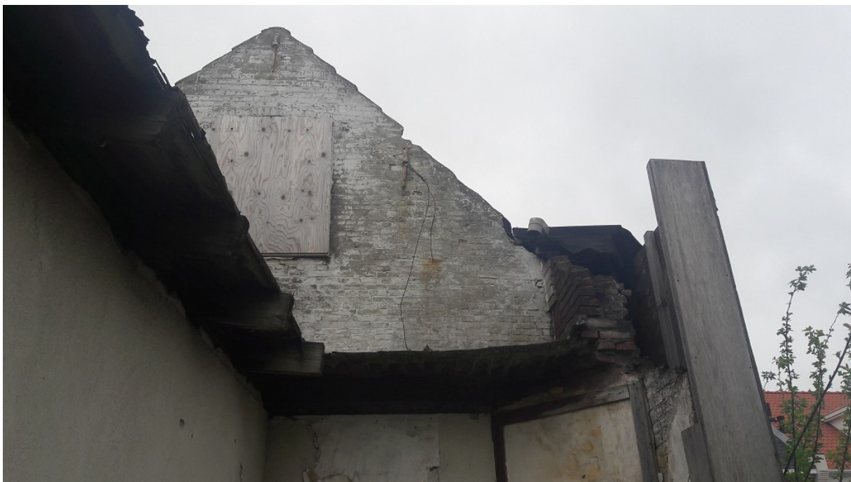
Achterzijde van de woning.
