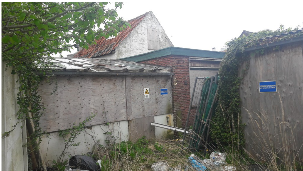
Plangebied gezien vanuit het noordoosten.
