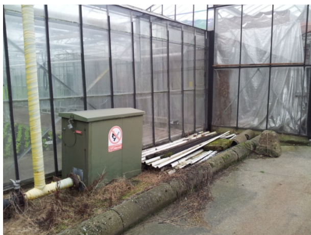
Foto 3: Vml. bovengrondse olietank
