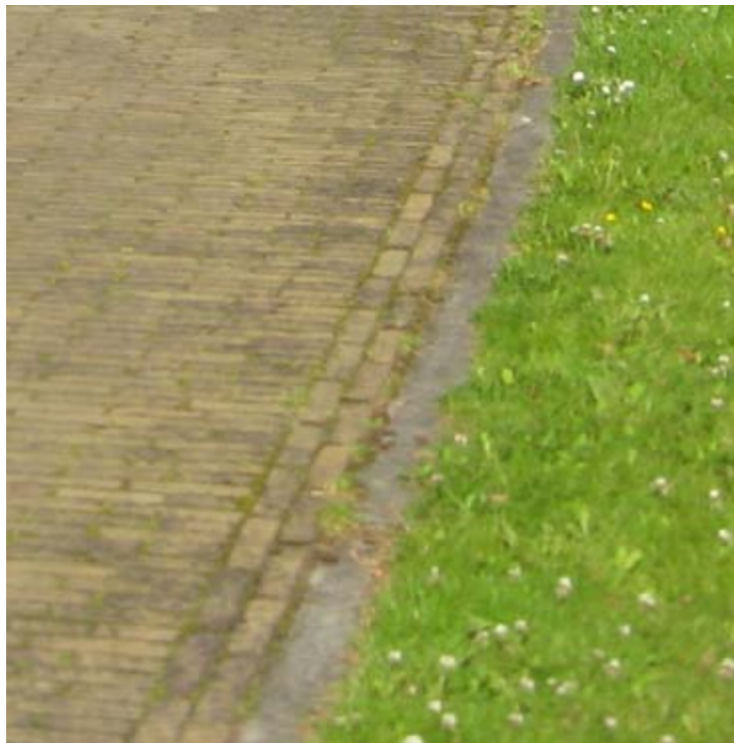
Inrit gebakken klinker dikformaat halfsteensverband
