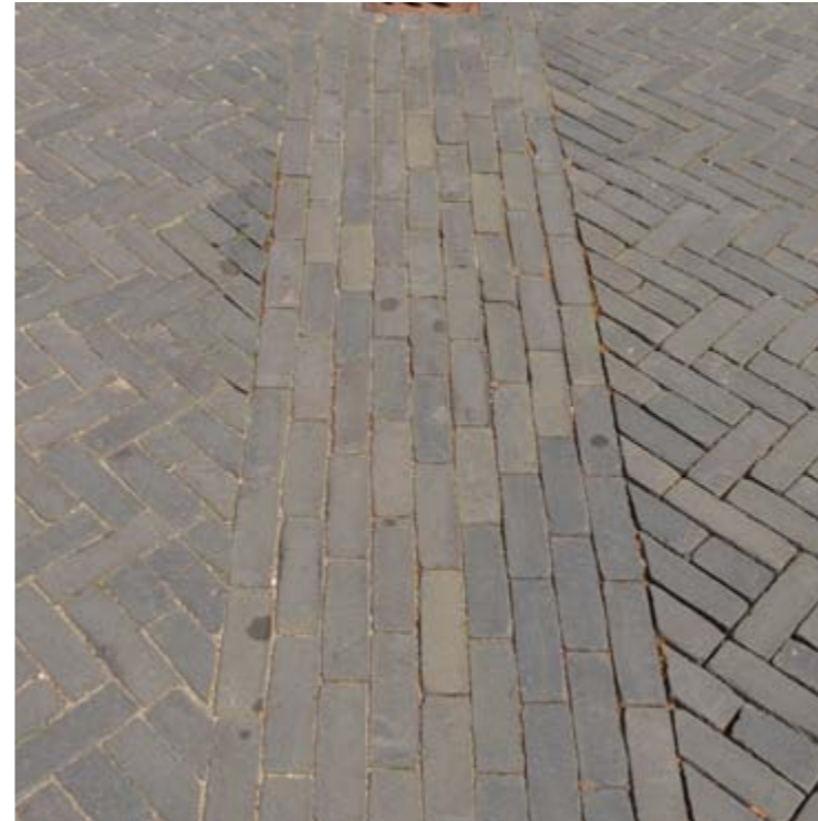
Rijbaan gebakken klinker dikformaat; Keper/elleboogverband met brede goot
