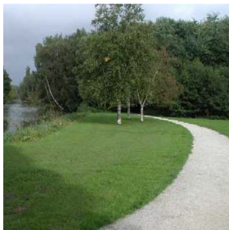
Het "karrenspoor" uitgevoerd in een asfaltverharding met sierslijtlaag
