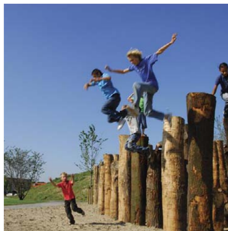
Palenwoud en 4 palen die te gebruiken zijn als goal, stammen diameter 20 - 50 cm. Hoogte boven maaiveld 50 - 150 cm, onderlinge afstand minimaal 30 cm. Stammen zijn van een duurzame houtsoort.
