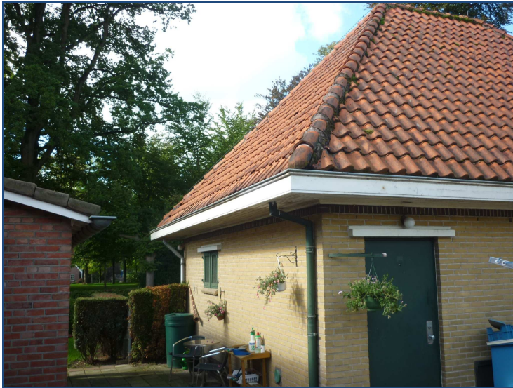
Twee losstaande gebouwen (bron: Building Design Architectuur)
