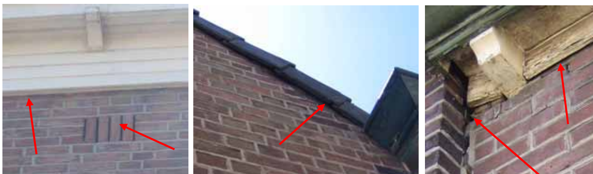
Afbeelding 4: Mogelijke verblijfplaatsen vleermuizen (foto's SAB, 2010)
