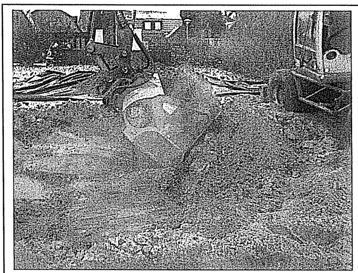
Foto 3 ontgraven tot visueel schone grond (olie-watertest en PID metingen)
