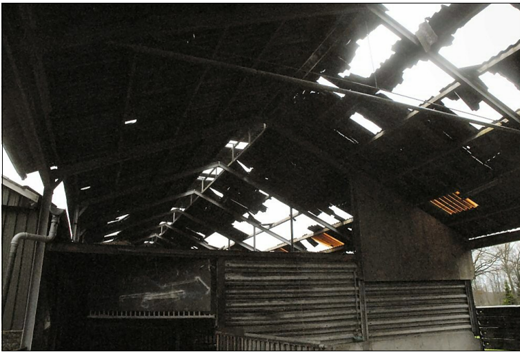
Schuur waar niet-asbesthoudende golfplaten zijn gebruikt.
