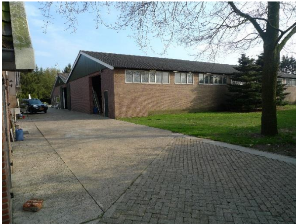
Foto 5: Te behouden caravanstalling
