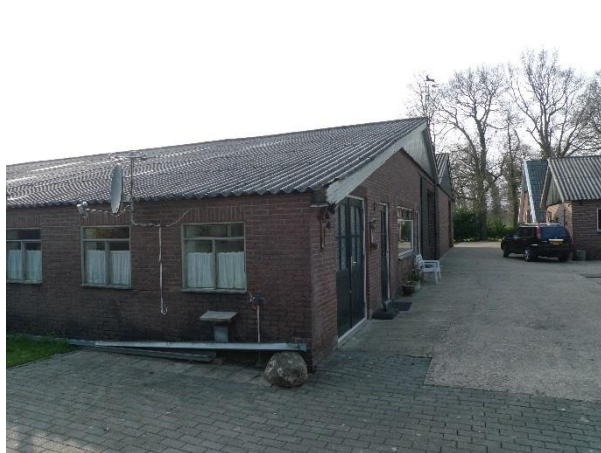
Foto 3: Noordgevel te verbouwen schuur
