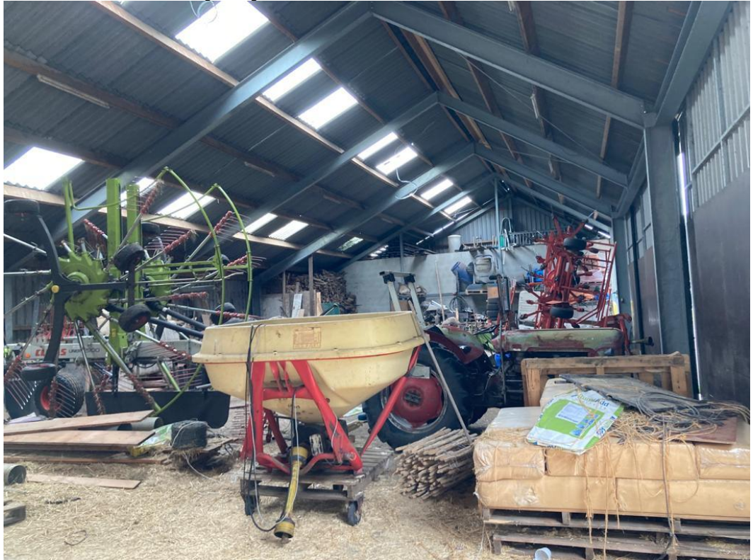
• Afbeelding 6: Ongeïsoleerd dak loods
