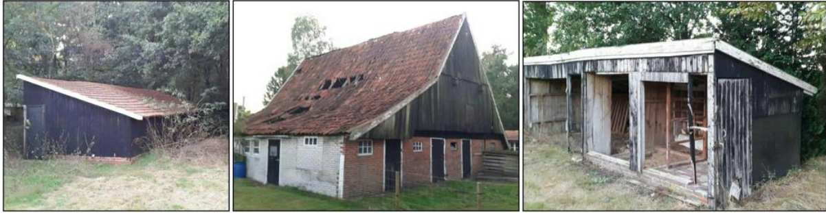
Afbeelding 3.2: Foto's de te slopen schuren nr. 1, nr. 2 en nr. 3 (Bron: Initiatiefnemer)
