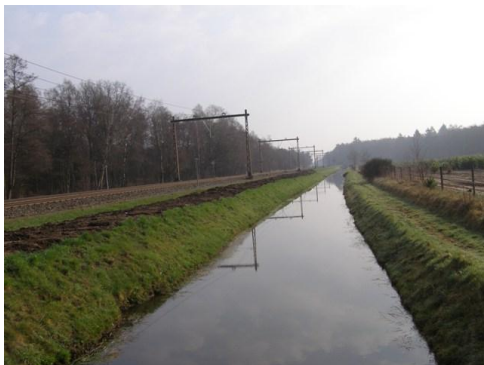
1 Koppelleiding en spoorlijn ten oosten van N737
