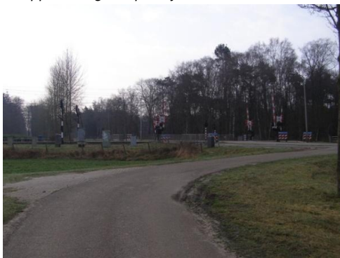
3 Spoorkruising vanuit het oosten
