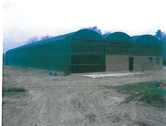
Technische installaties in de stal oplossen
