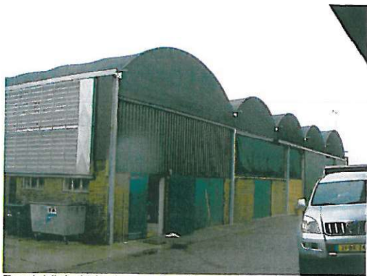
Eenduidigheid in de gevelindeling, details wegwerken
