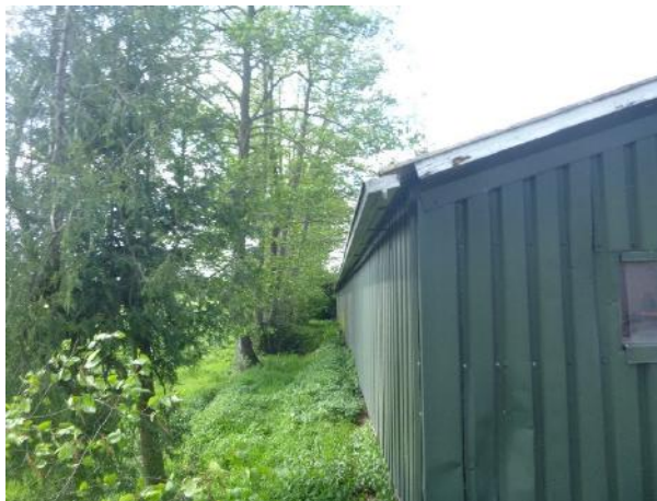
Zuidzijde te slopen schuur en dakgoot
