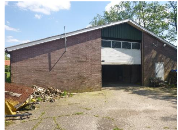
Westzijde te slopen schuur en ontluchting tank
