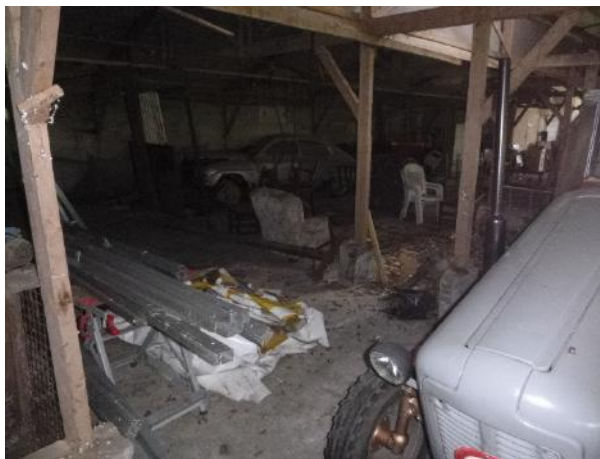
Binnenzijde te slopen schuur
