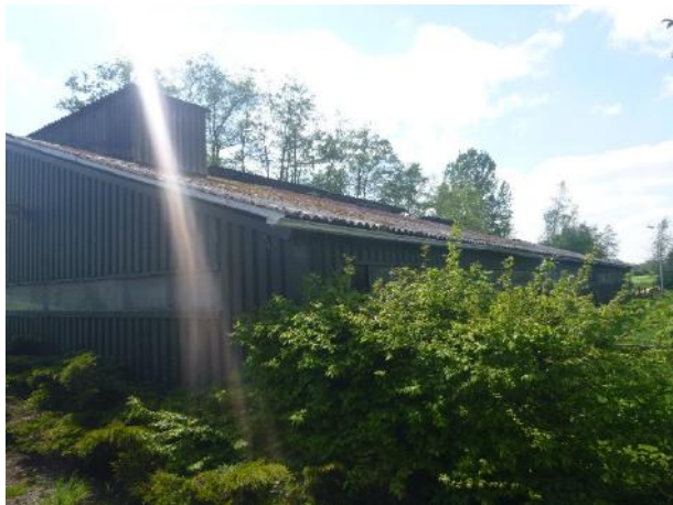
Noordoostzijde te slopen schuur en dakgoot
