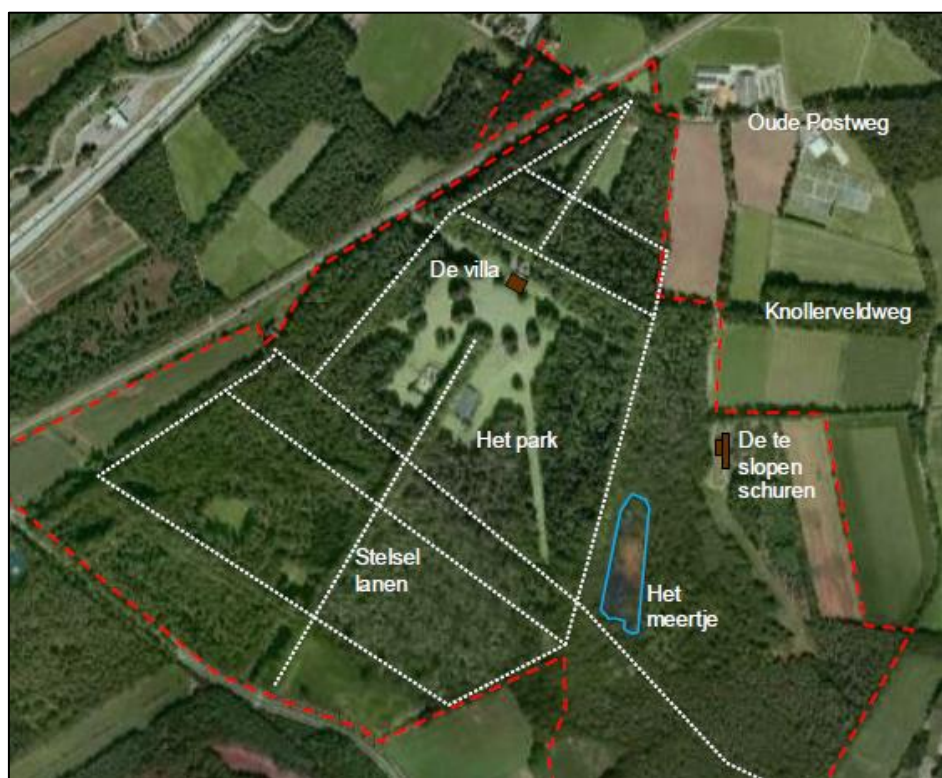
Figuur 2, Luchtfoto huidige situatie
